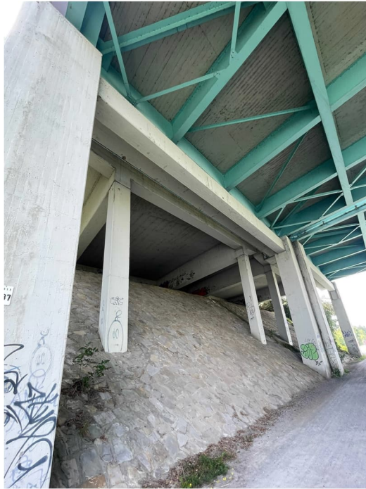
Foto 3a: Ansicht Süd-östlicher Pfeiler außen
