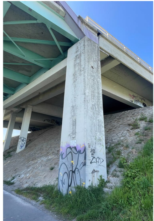
Foto 3b: Ansicht Nord-östlicher Pfeiler außen
