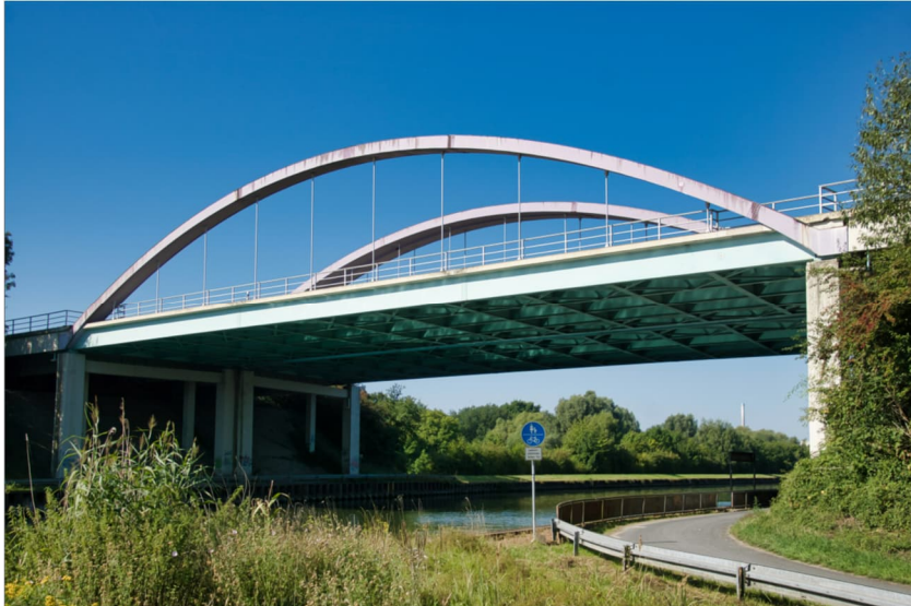
Foto 1 Seitenansicht - Betriebsweg WL-Pfeiler Nord- BW 4312 637 TBW2
