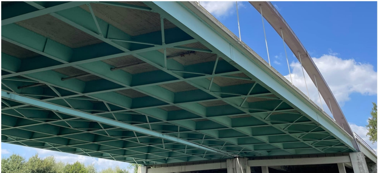
Foto 2: Unteransicht Überbau
